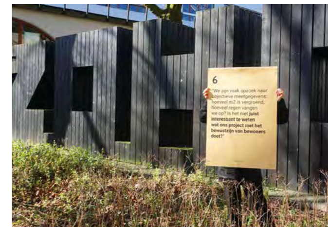
Zoho 'De Zohoregenletters, ontworpen door Studio Bas Sala zijn regenwaterbuffer en uithangbord voor de wijk ineen.'
